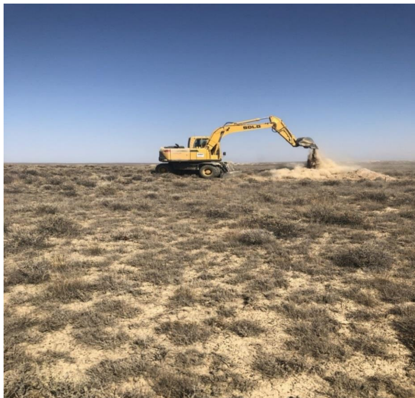
Рисунок 4.1 - Проходка канав и шурфов осуществлялась при помощи передвижного колёсного экскаватора (E7150F)
